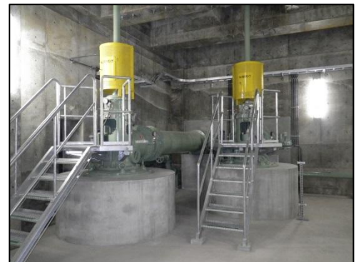
No. 1,2 雨水ポンプ立軸斜流ポンプ (Ⅱ型) φ600×55m 3/min×10.5m
