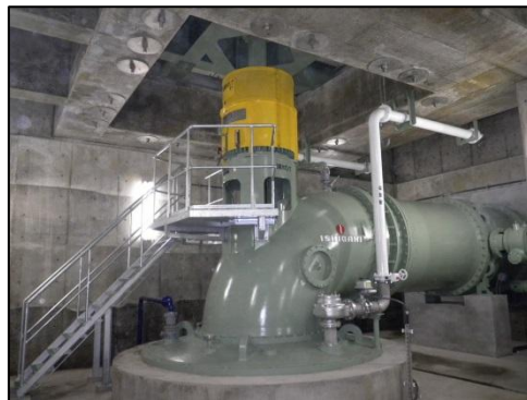
No. 3 雨水ポンプ先行待機型立軸斜流ポンプ (Ⅱ型) φ1800×562m 3/min×10.4m
