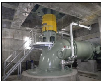
雨水ポンプ先行待機型立軸斜流ポンプ
