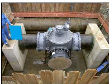
インサートバルブ T 型 C I P
