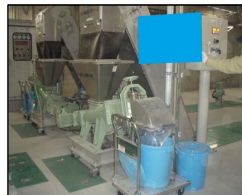
沈砂設備（微細目スクリーン裏書き史記微細目スクリーン除塵・し渣脱水機二軸対向スクリュース式）
