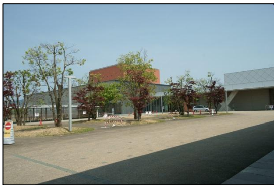
スクリューヒートポンプ 3 基 1100m 3 蓄熱槽
