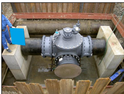
インサートバルブT型 C I P φ800×φ800
