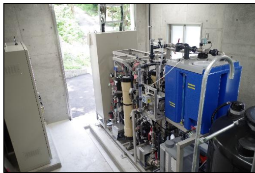
膜ろ過装置（MF 膜）
