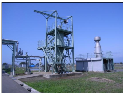
沈砂設備（微細目スクリーン裏かき式微細目 スクリーン除塵・し渣脱水機二軸対向スクリュース式）
