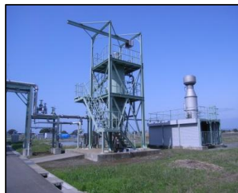
余剰ガス燃焼装置
