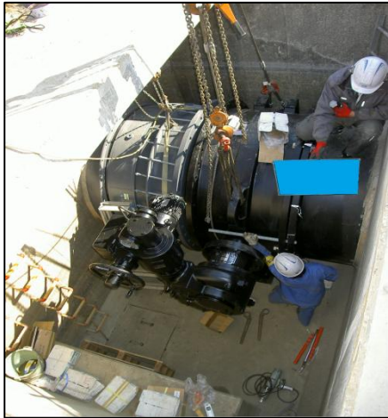
兵庫用水地区 第2号工事
