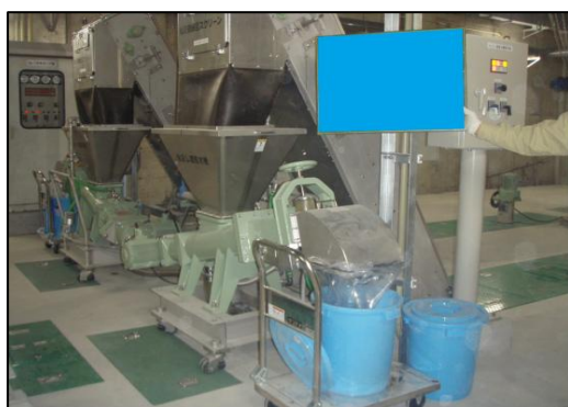
沈砂設備（微細目スクリーン裏かき式微細目 スクリーン除塵・し渣脱水機二軸対向スクリュース式）
