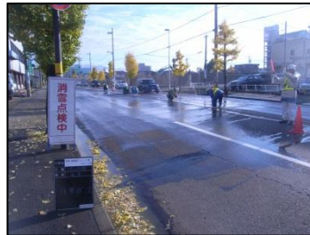
消雪点検工事
