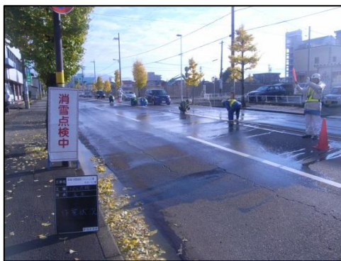
消雪点検工事作業状況
